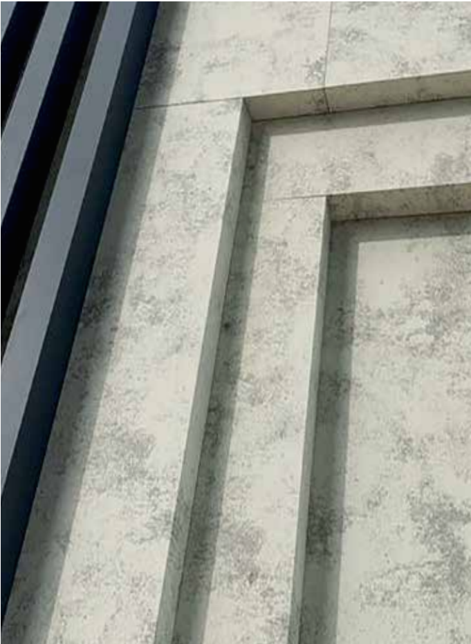
Бетон лайт В-2/03 T Здание банка, г. Ростов-на-Дону
