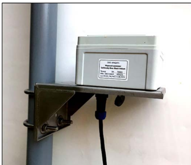
Рис. 5.2.1. Примеры установки на вертикальной трубе
