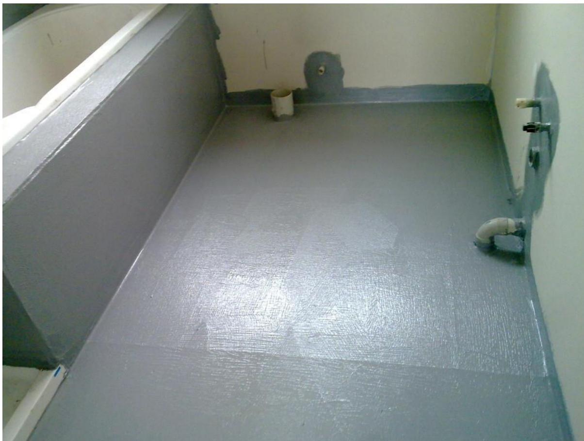
Гидроизоляция ванной комнаты
