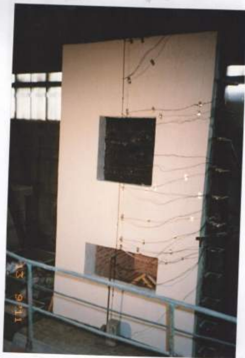
Рис.5.1. Общий вид перед огневыми испытаниями смонтированного на фрагменте железобетонной стены образца системы фасадной теплоизоляционной композиционной «ТЕРМОХА-УС».
