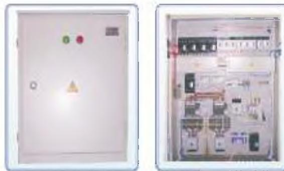
18 ЯЩИКИ АВТОМАТИЧЕСКОГО ВКЛЮЧЕНИЯ РЕЗЕРВА СЕРИИ Я 8300
