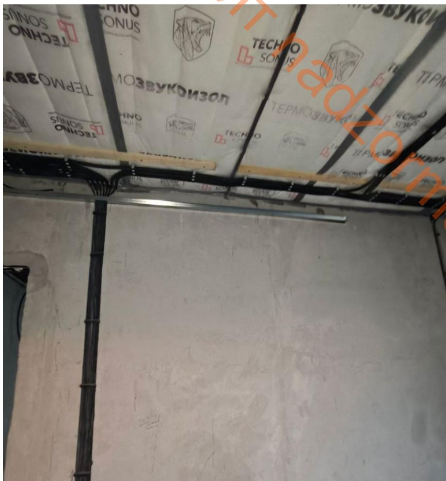
**Монтаж каркасной звукоизоляции стен выполнен с нарушением технологии монтажа, рекомендованного производителем.**
