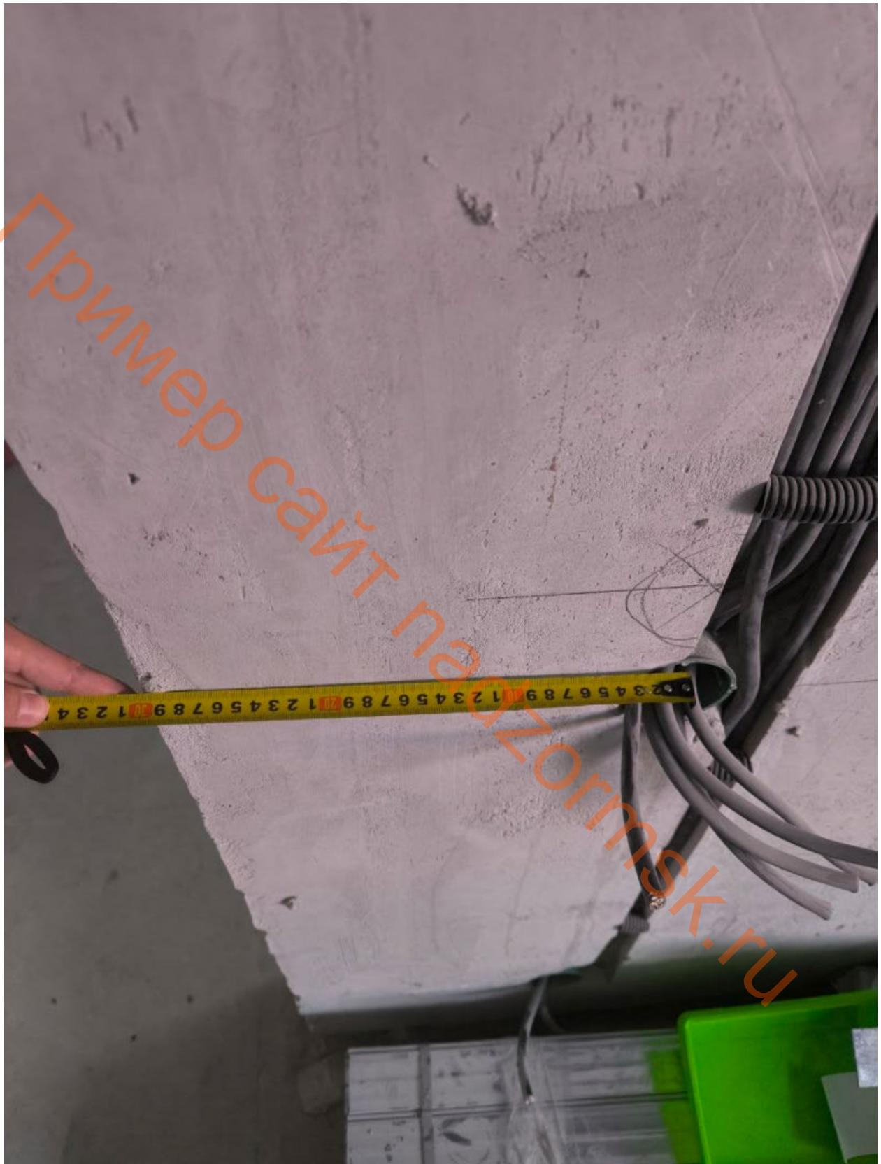
2. Привязка до центра выключателя 260 мм. вместо 250 мм.
