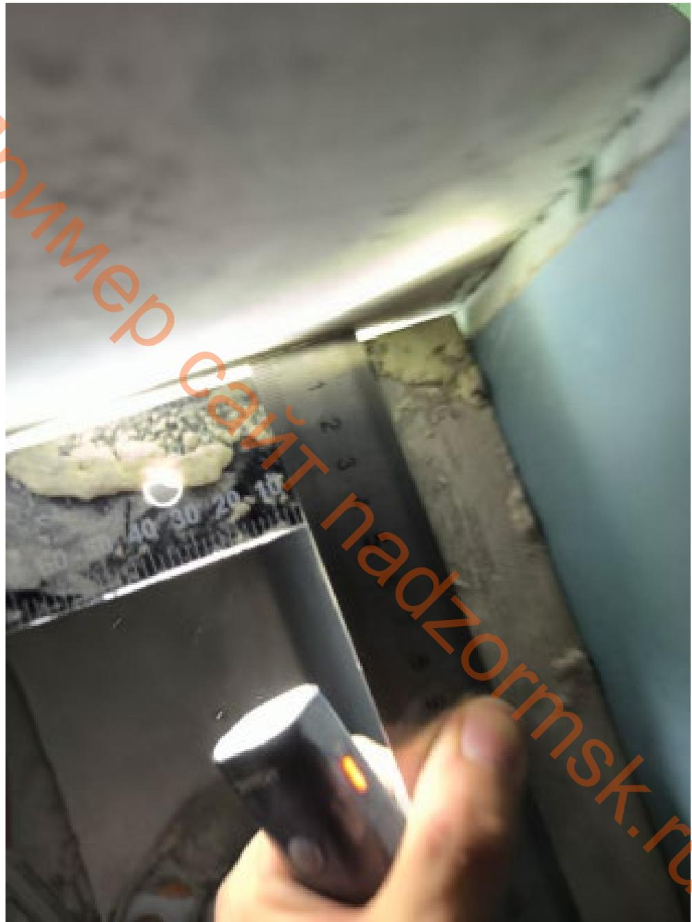
2. Отклонение угла стены от вертикали 5 мм.
