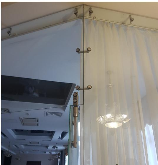
Крепление стекла толщиной от 10 до 11 мм через коническое отверстие к плоскости под углом 90 град.
