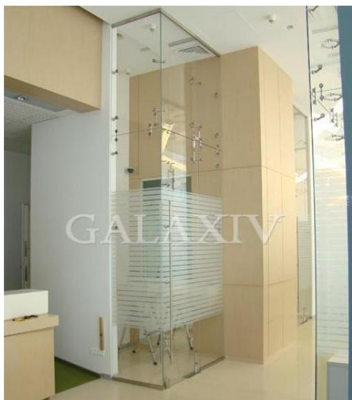
Крепление двух стеклянных полотен толщиной от 10 до 11 мм через коническое отверстие в стекле под углом 180 град.
