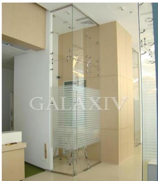
Крепление двух стеклянных полотен толщиной от 10 до 11 мм через прямое отверстие в стекле под углом 180 град.
