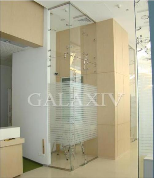
Крепление трех стеклянных полотен толщиной от 10 до 12 мм через коническое отверстие в стекле под различным углом.
