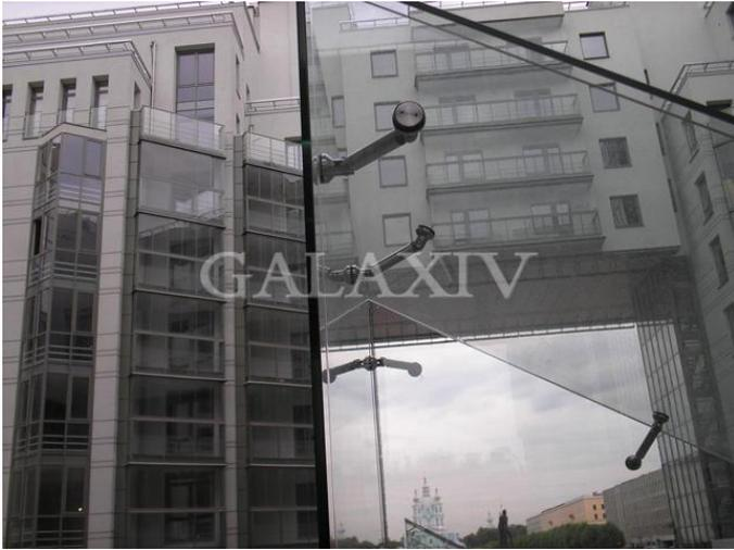
Крепление стеклянной панели толщиной от 8 до 21 мм через коническое отверстие к полу/потолку/стене.
