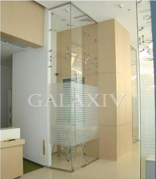
Крепление двух стеклянных полотен толщиной от 8 до 21 мм через коническое отверстие к стекло-стекло.
